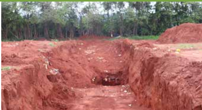
Foto 3 - Aterro Sanitário de Barão de Antonina e Itai.
