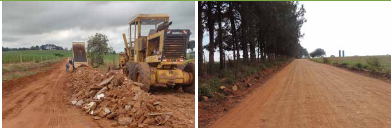
Foto 15 – Uso de RCC segregado em manutenção de estradas, em Manduri.
