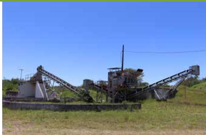
Foto 14 – Conjuntos de reciclagem de RCC inoperantes em Avaré e Taquarituba.
