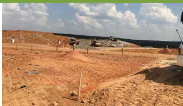
Foto 1 - Aterro Sanitário em Piratininga.
