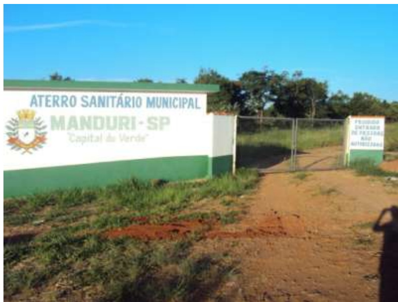
Figura 8 – Entrada do Aterro
