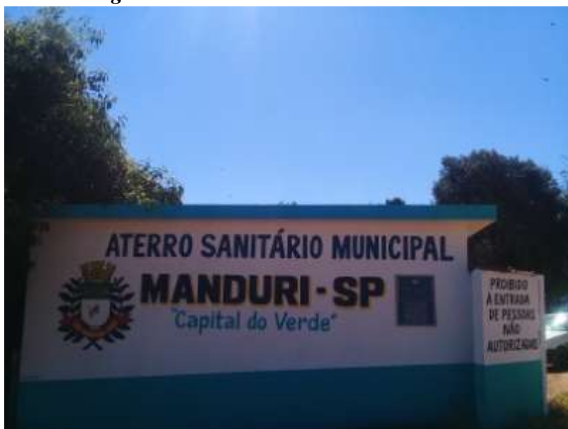
Figura 12 – Entrada do aterro controlado
