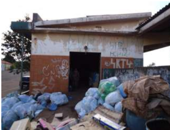
Figura 15 – Galpão de triagem
