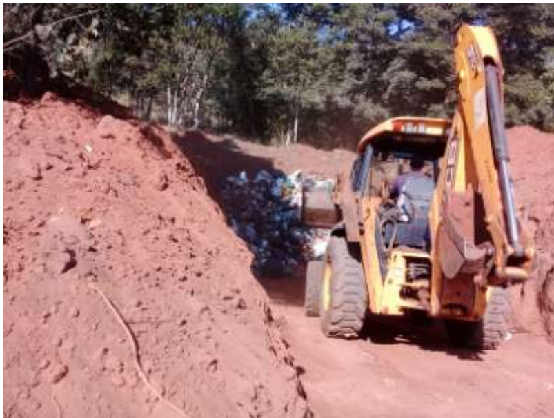
Figura 14 – Vala aberta recebendo o RSU diário
