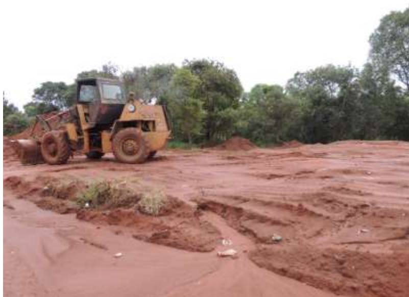
Figura 13 – Local da última vala
