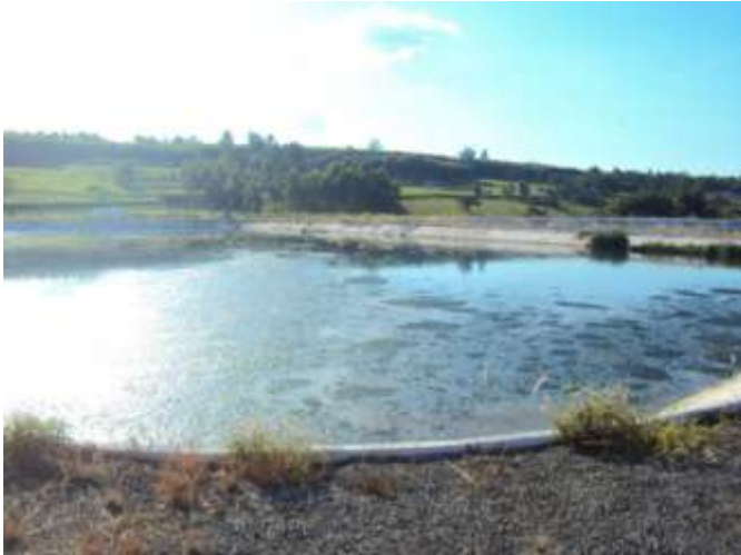
Figura 66 - Lagoa Anaeróbia. Fonte: LPL Engenharia, 2012.
