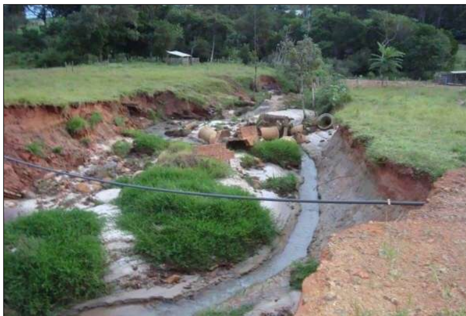
Figura 78 – Erosão e assoreamento de córrego.
