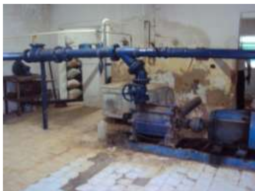
Figura 39 – Bombas e equipamentos, hoje hoje desativado. não está em uso.
