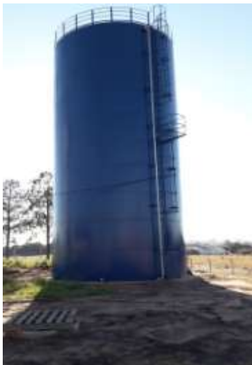
Figura 53 – Reservatório Saeman II
