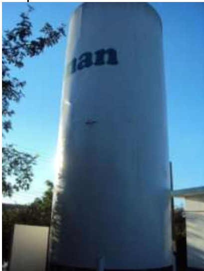
Figura 46 – Reservatório CDHU (São Berto). Fonte: LPL Engenharia ,2012.
