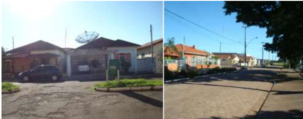
Figura 80 – Falta de infraestrutura em local de recepção de água.
