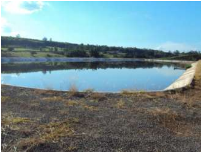
Figura 67 – Lagoa Facultativa. Fonte: LPL Engenharia, 2012
