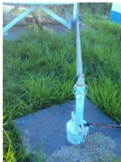
Figura 47 – Poço São Berto II. Fonte: LPL Engenharia, 2012.
