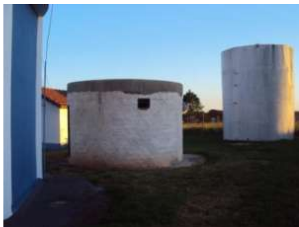
Figura 42 – Reservatório em construção (não está operando).
