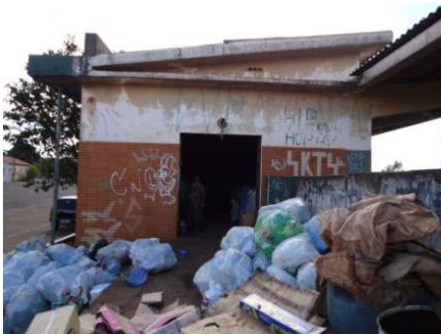
Figura 95 – Fotografia do galpão de separação do recicláveis. Fonte: LPL Engenharia e Mapeamento Digital, 2012.
