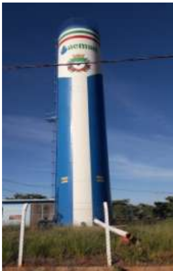
Figura 57 – Reservatório Santo Antônio
