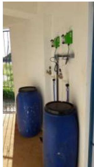
Figura 54 – Dosadores de Cl - e F - do Reservatório Saeman II
