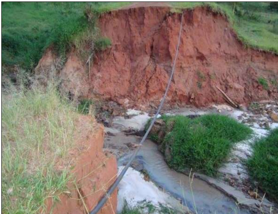
Figura 77 – Erosão em manancial.
