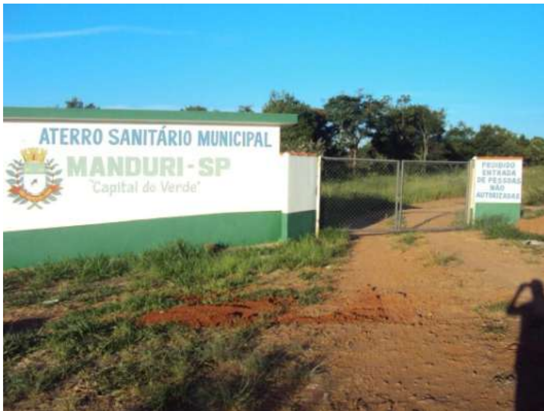
Figura 87 – Entrada do Aterro Sanitário Municipal de Manduri.
